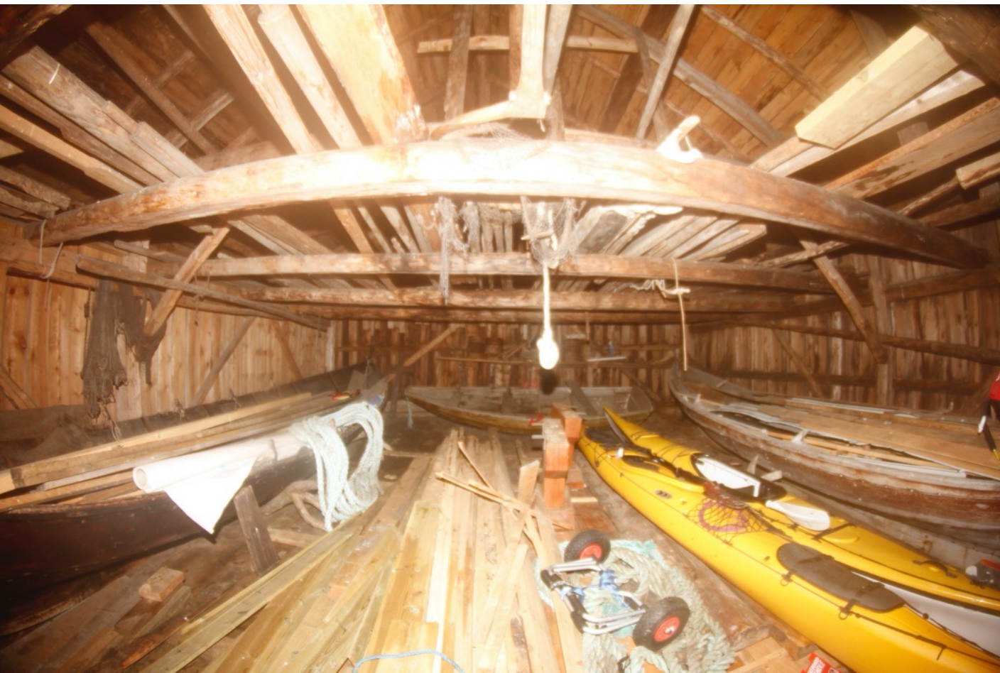
Bilde tatt mot sørvegg med vidvinkel
