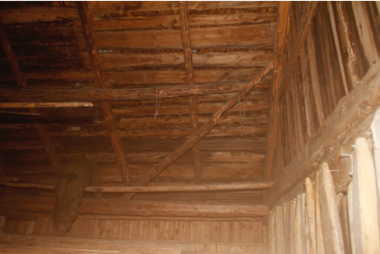
Bilde tatt østsiden taket
