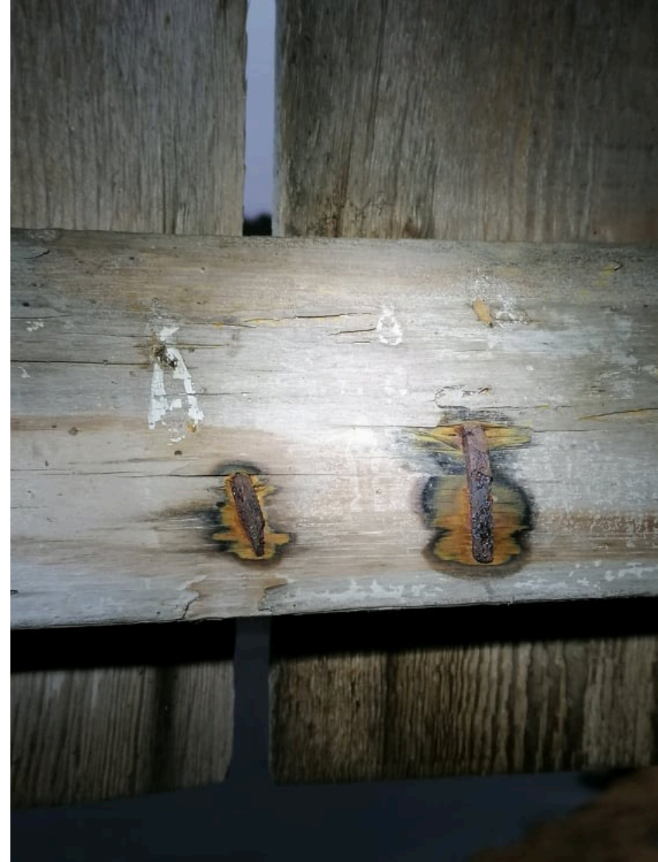
Bilde tatt på innside av kledning
